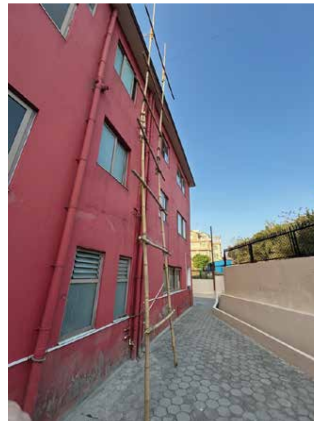
L'arrivo e la posa dell'impalcatura
